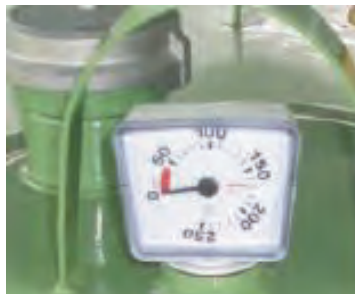
Figura 16: Esempio di indicatore del livello di riempimento del serbatoio
