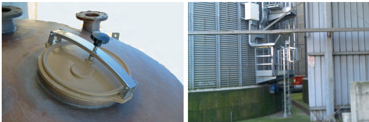
Figura 20 a) e b): esempi non esaustivi di via di ingresso o uscita limitata e/o difficoltosa: a) passo d'uomo su serbatoio, b) scala alla marinara per accesso all'entrata dei silos - fonte Contarp, Inail)
